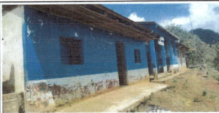
Foto 5: Se observa , canales faltantes, y pinturas desgastadas en todos los módulos.
