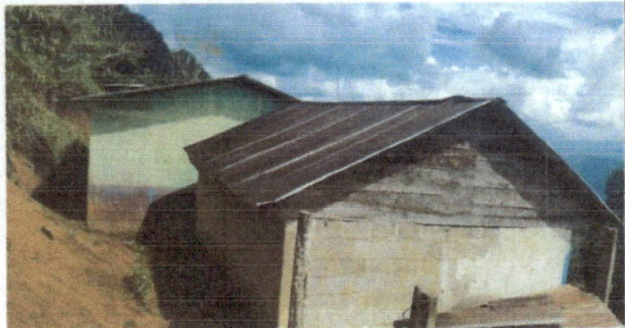
Foto 1: Se observa deterioro y oxidación de techo, desprendimiento de pintura en las paredes del modulo No. 1
