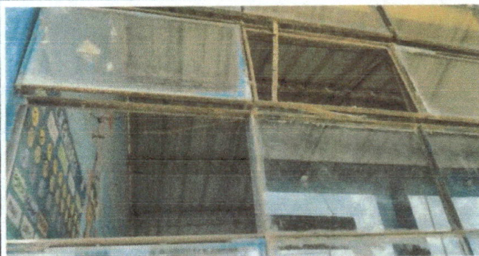
Foto 4: Se observa deterioro en los balcones de los modulos y vidrios faltantes.
